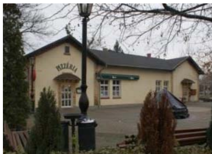
régi vasúti épület – ma pizzéria...
