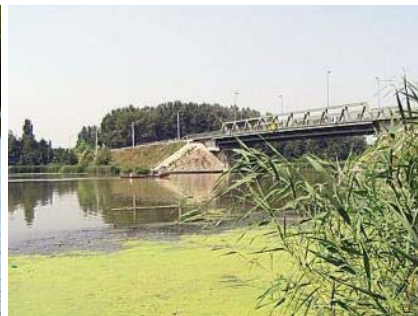
...a Taksony híd Szigethalom és Szigetszentmiklós irányában...
